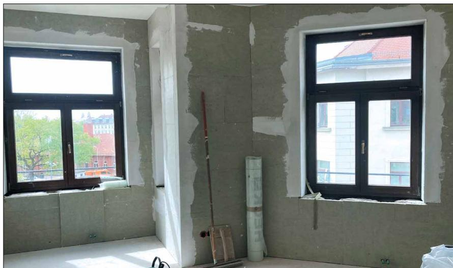
Inneo-Baustelle: Das System erfüllt in nahezu allen Ausgangskonstruktionen den energetischen Mindestwärmeschutz. Aufgrund der leistungsstarken Steinwolle-Dämmplatten ( $0,035 \text{ W/mK}$ ) geht die Inneo-Sanierung nur mit minimalem Raumflächenverlust einher.
