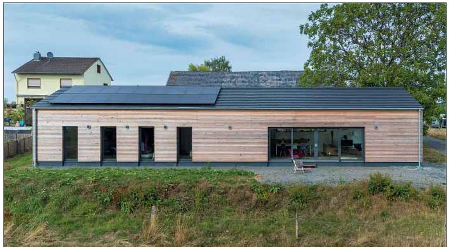
Auf der Südwestseite sind alle Fenster bodentiefe und auf dem Dach Solarpaneele (Photovoltaik) angebracht, um die umweltfreundliche Luft-Wasserwärmepumpe – mit Eigenstrom – noch ökonomischer zu betreiben.
