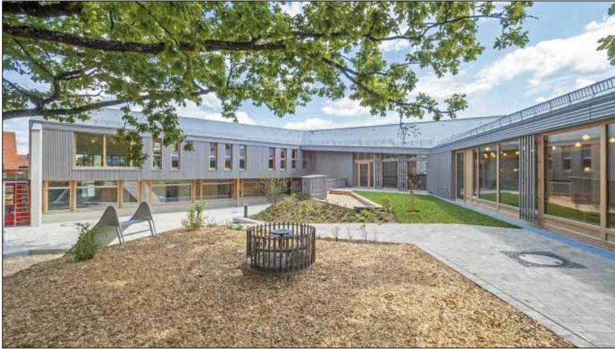
Das »Kinderhaus unterm Blätterdach« erhielt ein homogenes Dach mit Cedral Dachplatten in Doppeldeckung. Die zinkgrauen Faserzementplatten fassen Neu- und Altbau zu einer Einheit zusammen.
