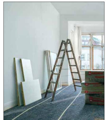
Einfach, aber wirkungsvoll: Die vollflächig verklebten Dämmplatten werden mit Gewebe armiert und anschließend verputzt. Das System funktioniert ohne Dampfbremse.
