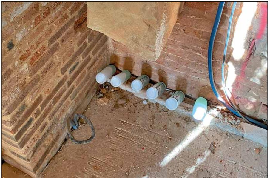
Zur minimalinvasiven Mauertrockenlegung wurde eine kriechfähige, niederviskose Silikonharz-Lösung über Bohrkanäle injiziert, die mit der Feuchtigkeit im Mauerwerk reagiert und eine unverrottbare Horizontalsperre bildet.
