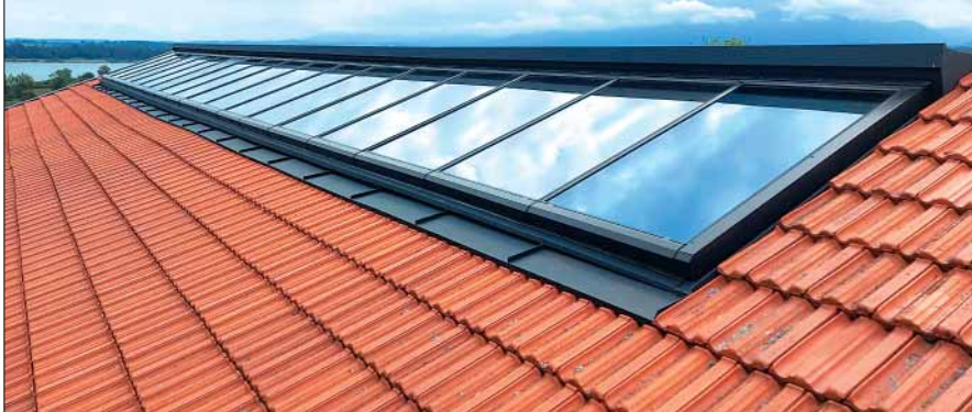
Knapp 20 m misst das Lichtband. Außer den 16 Glasmodulen umfasst es noch zwei Blindelemente zum Abdecken der Abschlüsse an die Holztrennwände.
