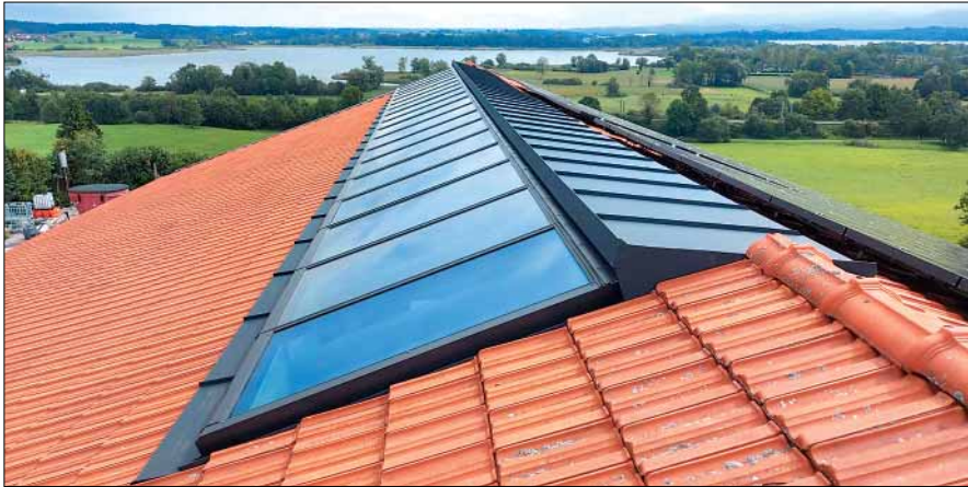
Während das Lichtband von Glasolux auf der Nordseite des Daches platziert ist, befindet sich auf der Südseite eine PV-Anlage. Eine Stehfalzverblechung in identischer Breite bildet den dazwischenliegenden First.
