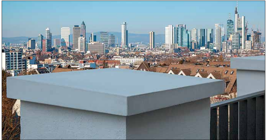
Neben dem Einsatz von Klinker und verschiedenen Putzarten wurden auch Caparol Faserbeton-Elemente in Form von Stützen- und Brüstungsabdeckungen verbaut.
