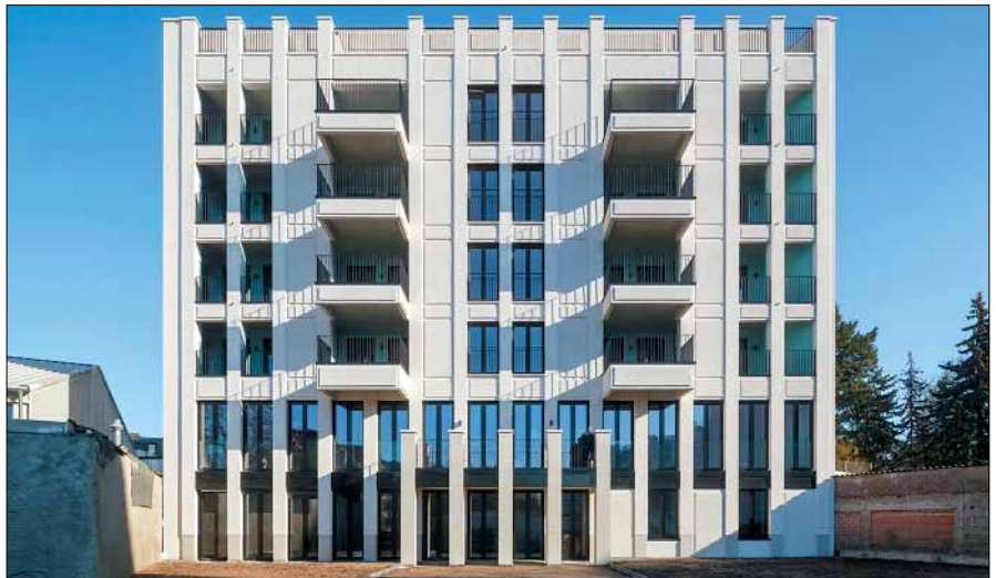
Ruhige Farben und das Zusammenspiel aus Putzvarianten, Klinker und Faserbeton-Elementen sorgen für eine dezente, natürliche und einladende Optik der Ostfassade, die das Entrée des Gebäudekomplexes bildet.
