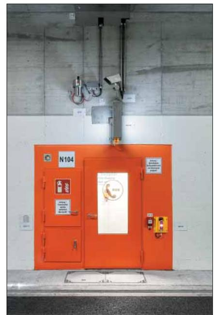
*Die gelieferten Türösungen bestehen aus robustem Edelstahl und sind je nach Einsatzzweck mit Signal- und Fluchtwegleuchten ausgestattet.*
