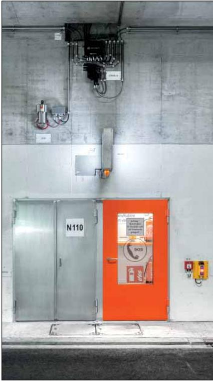
Die in Lizenz gefertigten Abschlüsse wurden präzise an die anspruchsvollen Bedingungen des Tunnelbaus angepasst und erfüllen höchste technische Anforderungen.
