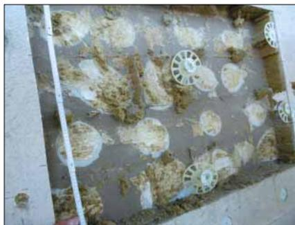
Die Probeöffnung zeigt, wie gut der Werk trockenmörtel Heck K+A FILL hinter dem Alt-WDVS verlaufen ist und Hohlräume passgenau ausfüllt. So wird die Standsicherheit des neuen Dämmsystems gewährleistet.
