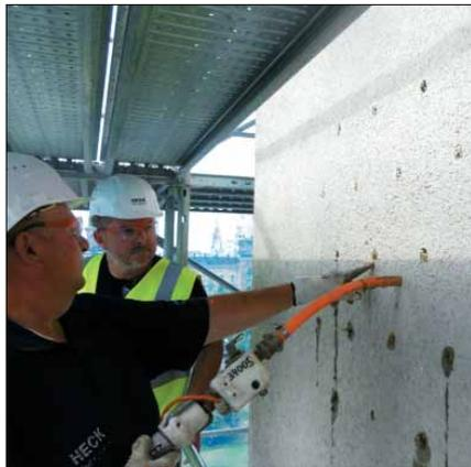
Der Klebemörtel wird punktuell mittels Klebepistole zwischen Wand und Bestandsdämmung eingespritzt. Hierdurch entsteht eine dauerhafte Verbindung zwischen Untergrund und Alt-WDVS.
