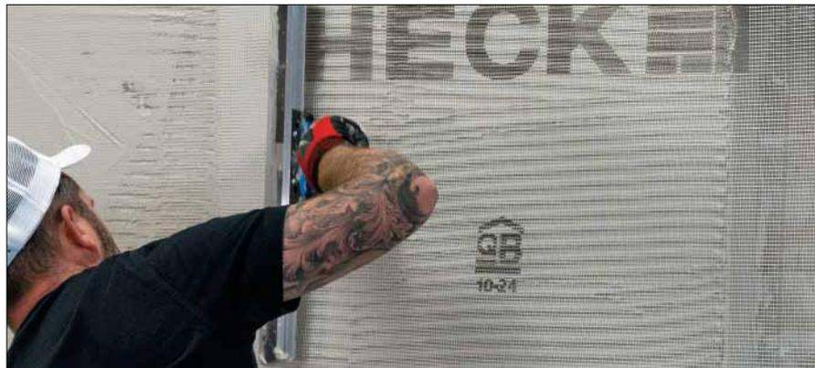
Die neuen Dämmplatten werden armiert sowie anschließend verputzt. Die Standsicherheit ist gewährleistet.
