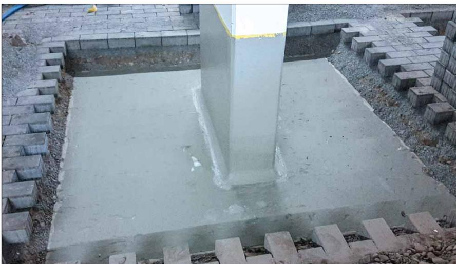
StoCretec FB eignet sich als Abdichtung zum Schutz überschütteter Bauteile unter Pflasterbelägen sowie als Oberflächenschutzsystem im Sprüh- und Spritzbereich von chloridbelastetem Wasser.
