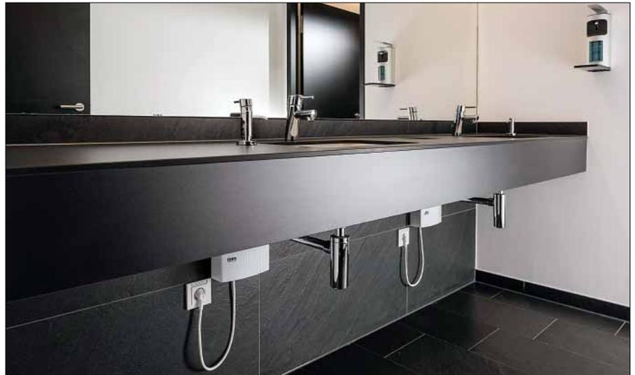
*AEG Klein-Durchlauferhitzer MTD 350 sorgen für Warmwasserkomfort und Effizienz an allen Handwaschbecken im Gebäude. Bei der Nutzung besteht nur ein kleiner Warmwasserbedarf, der mit 3,5 kW Leistung ausreichend gedeckt wird (weitere Ausführungen bietet AEG Haustechnik bis 6,5 kW).*
