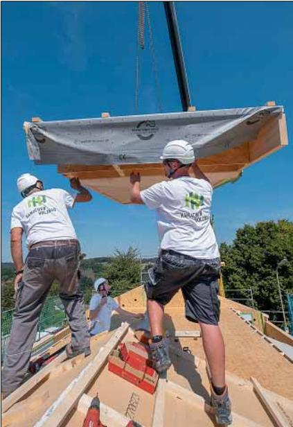
weise mit vorgefertigten Bauteilen errichtet. So konnte es innerhalb von zwei Tagen gebaut werden. Den Sockel für das kellerlose Haus bildet eine nicht sichtbare Betonplatte. Die darauf aufbauenden Wände sind 37 cm dick und bestehen nahezu vollständig aus Holz und Naturgips. Als Dämmstoff dient Zellulose. Die Fassade aus naturbelasse-
