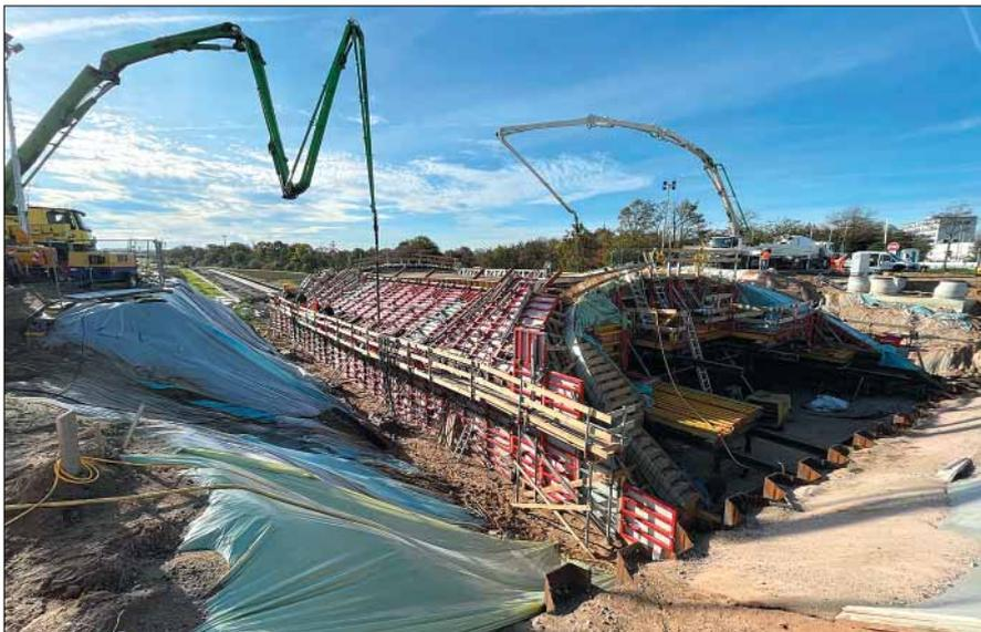
Um die speziellen trompetenförmigen Rundungen des Radschnellwegtunnels in Mannheim zu realisieren, wurde die alkus® SF Flex Schalungsplatte in 4 mm Stärke für die Innenschalung (Sonderschalung) eingesetzt.
