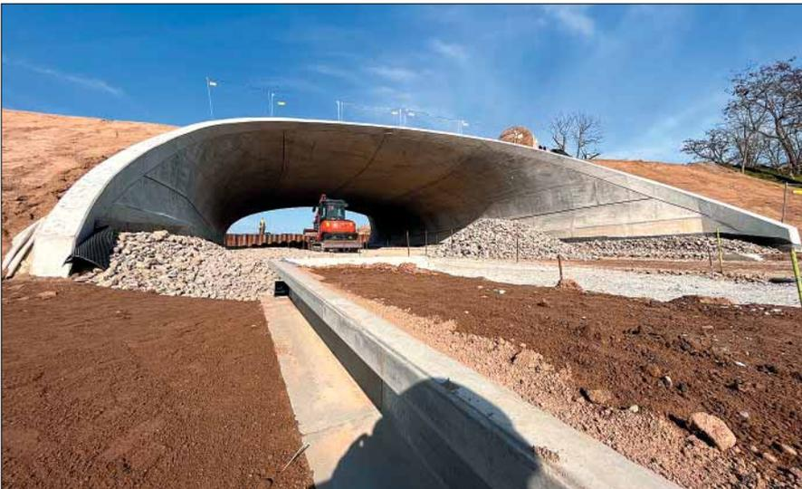
Der 40 m lange Tunnel über dem Schnellradweg auf dem BUGA 23-Gelände wurde in offener Bauweise realisiert.
