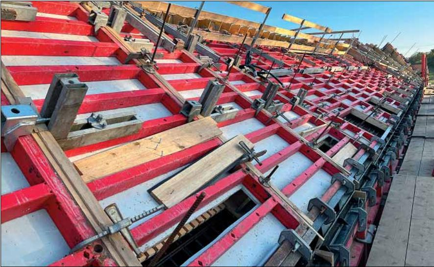
Die Außenschalung (Konterschalung) des BUGA-Tunnels wurde mit dem MEVA Mammut XT-System (Rahmenschalung) mit verbauten alkus® AL Schalungsplatten in 20 mm Stärke umgesetzt.
