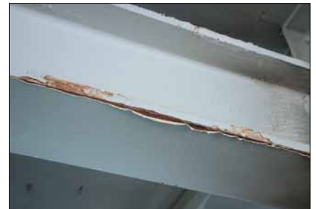
Asbesthaltige Brandschutzbeschichtungen der Stahl-Unterzüge.
