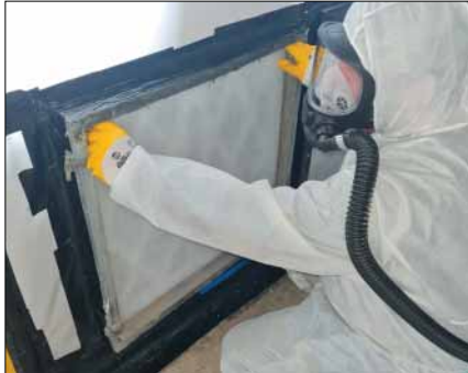
Austausch eines Filters der lufttechnischen Anlage.
