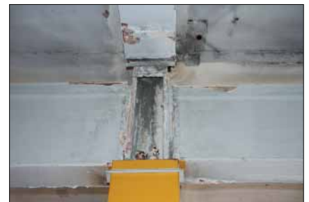
Asbesthaltige Brandschutzbeschichtungen der Stahl-Unterzüge.
