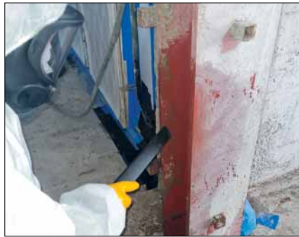
Mit Spezialsaugern werden verbliebene Asbestfasern zuverlässig entfernt.
