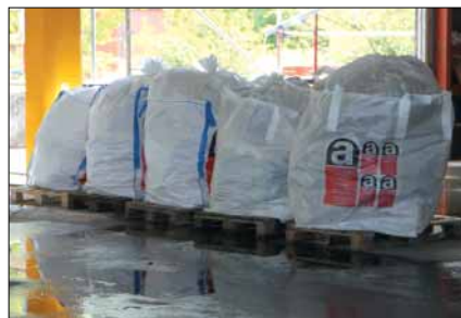
Bereit zum Abtransport: Das »Schwarzmaterial« wird auf einer geeigneten Deponie entsorgt.
