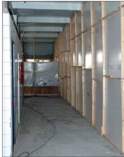
Mit Holzrahmen und Folien abgeschotteter »Schwarzbereich«.
