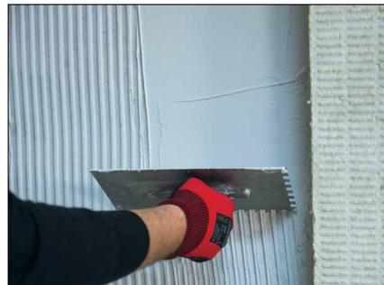
*Die Verarbeitung des WDV-Systems erfolgt klassisch. Der spezielle Klebemörtel wird auf den Holzuntergrund aufgebracht.*
