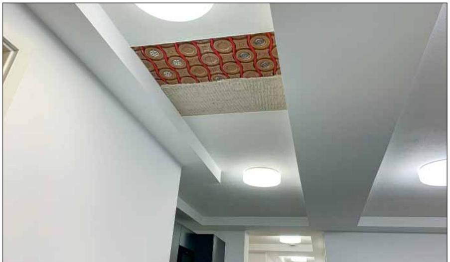
Auf der ganzen Fläche wurden Natur-Klimadecken aus Hochleistungs-Lehmodulen installiert. Eine Schauffläche zeigt den Systemaufbau.
