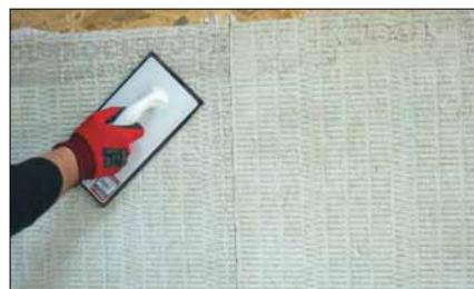
*Anschließend werden die Dämmplatten angedrückt und eingeschwommen.*
