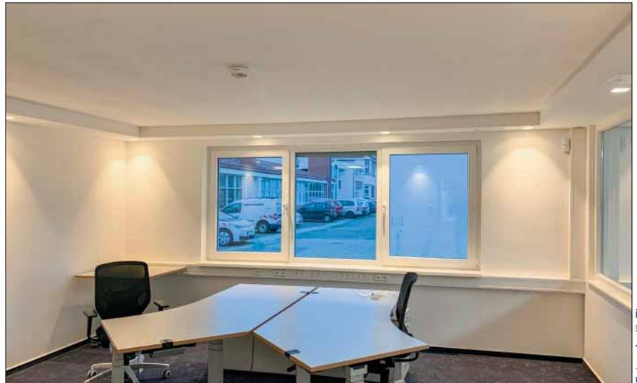
Die Natur-Klimadecke heizt die Büros mit Strahlungswärme von oben. Das Lehm-/Ton-Gemisch absorbiert Gerüche und Schadstoffe aus der Luft.
