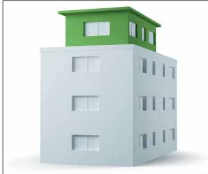
An Gebäuden bis maximal 22 m ist eine nicht brennbare WDVS-Ausführung an der Aufstockung bzw. am Dachappartement in Holzrahmenbauweise möglich.
