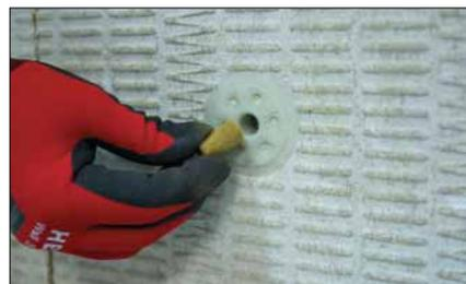
*Die Verdübelung erfolgt mittels Schraubdübel.*
