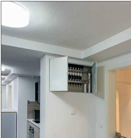
Der Heizkreisverteiler befindet sich im Flur. Von hier aus werden die einzelnen Heiz-/Kühlflächen über ein Ringleitungssystem versorgt.
