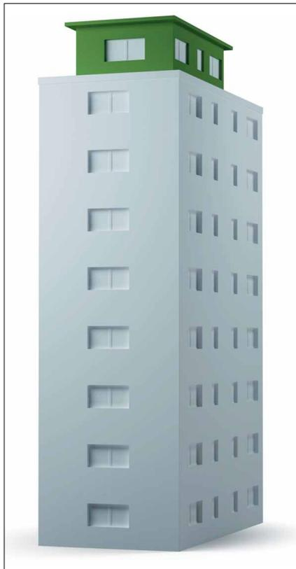
Mit Heck Holzbau A2 ist eine nicht-brennbare WDVS-Ausführung an Gebäuden über 22 m an der Aufstockung bzw. am Dachappartement in Holzrahmenbauweise möglich.
