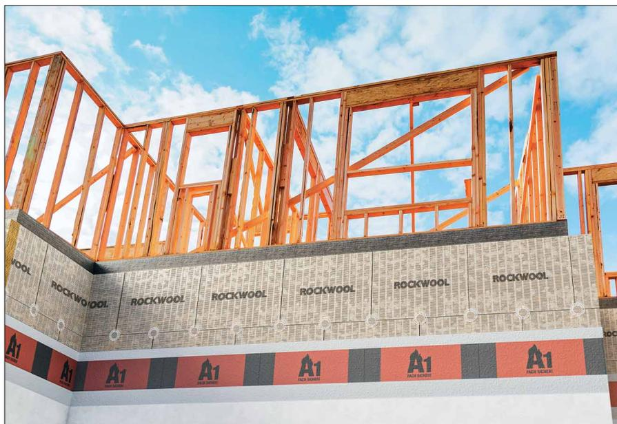
*Heck Holzbau A2 transportiert als nicht brennbares WDV die Nichtbrennbarkeit von der Massiv- in die Holzrahmenbauweise.*
