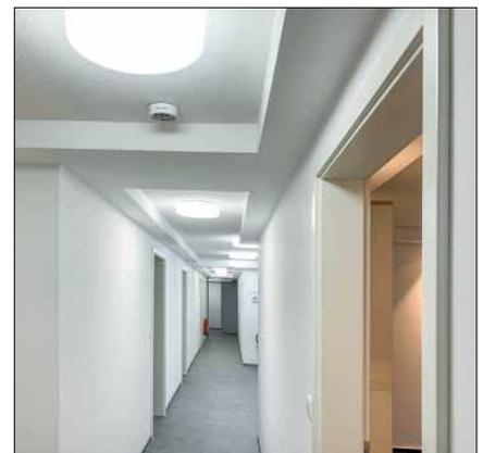
Durch die Fähigkeit der Natur-Klimadecke zur Feuchtregulierung ist im sommerlichen Kühlbetrieb keine Anlage zur Raumluftentfeuchtung nötig.
