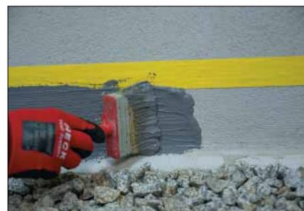
*Heck 2K Turbo DB ist nach der Aushärtung radondicht, UV-, frost- und tausalzbeständig.*
