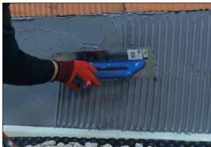
*Die Abdichtung mittels Dickbeschichtung erfolgt in zwei Lagen. Bereits drei Stunden nach dem Auftrag der ersten Lage kann die zweite Lage aufgebracht werden.*
