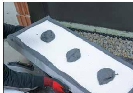
*Dämmplatten können mit Heck 2K Turbo DB sowohl auf mineralische wie auch bituminöse Untergründe geklebt werden.*
