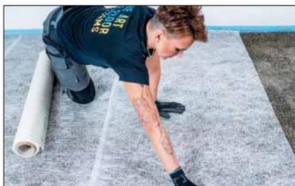
*Das Renoviervlies Uzin RR 201 ist Bestandteil des Systems und trägt zur Stabilisierung und besonderen Tragfähigkeit bei. Das Renoviervlies aus hochzugfesten Glasfasern wird auf der Ausgleichsschicht überlappend verlegt, bevor der selbstverlaufende Dünnestrich aufgebracht wird.*
