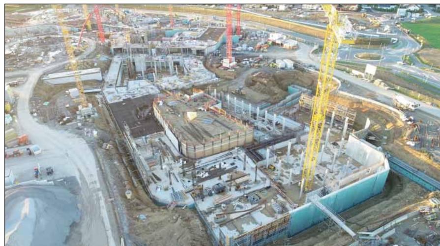
Über fünf Untergeschosse und bis zu sechs Obergeschosse erstreckt sich der Gebäudekomplex, hier das Gebäude E mit Arbeiten am Untergeschoss 1.
