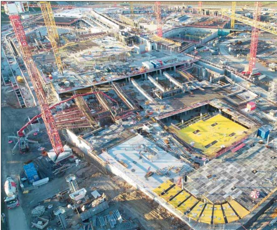
Beim größten der im Rohbau befindlichen Gebäude (Gebäude A) Gebäude ist hier der erste Abschnitt der Decke über dem Erdgeschoss eingeschalt.
