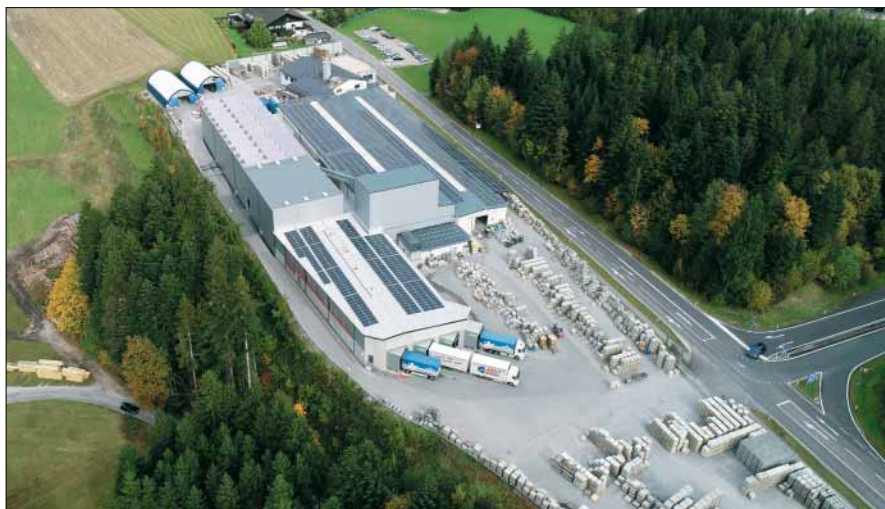
Modernste High-Tech-Fertigung – das Stammwerk im österreichischen Oberwang.
