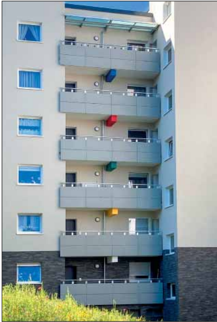
Gut zu erkennen sind auch die farbigen Kragarme unter den Laubengängen.
