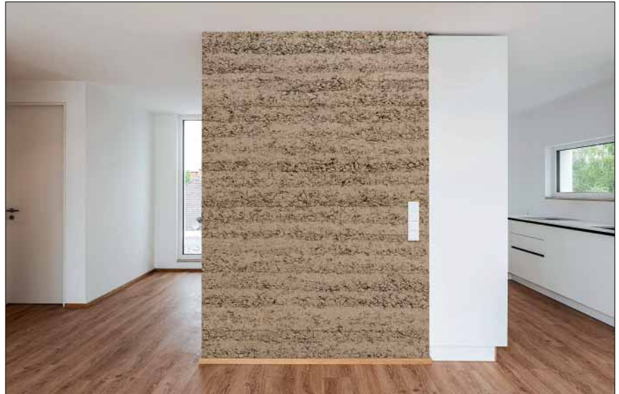
Unverputzte Stampflehmwände zeigen deutliche Schichtstrukturen, die von der verdichteten Lehm Masse herrühren. Diese Strukturen können je nach Art der Schalung und des eingefüllten Materials variieren. Stampflehmwände werden daher auch aus architektonisch-ästhetischen Gründen eingesetzt.
