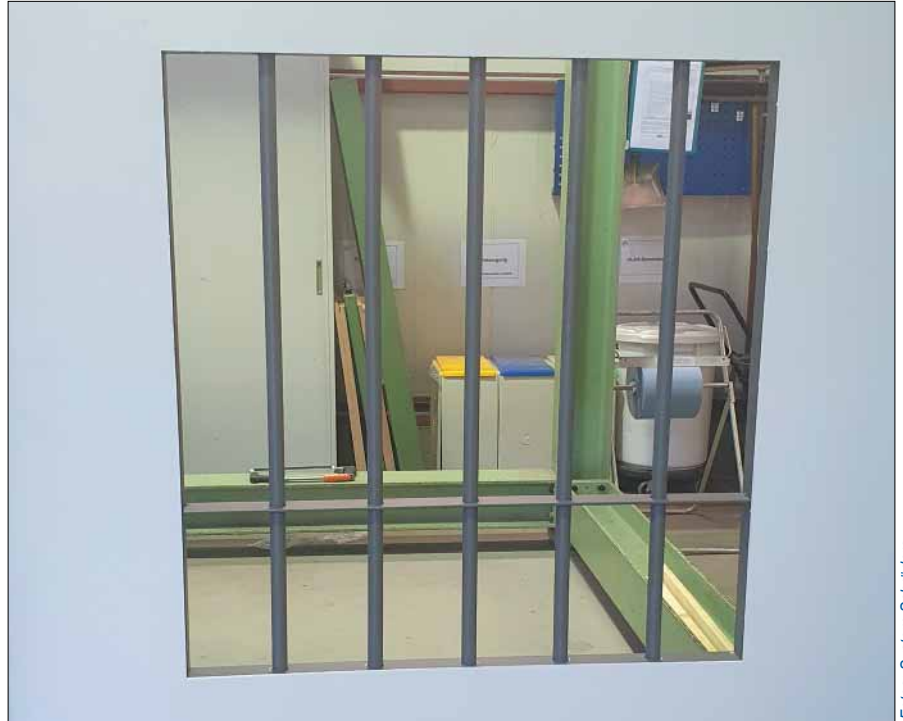
Neben dem Einsatz als Feldelement in Türen, lassen sich Lamellenlüftung und Stabgitter auch in Wandöffnungen einbauen.
