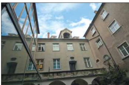
Ansicht des Gebäudes vom Innenhof mit der Krangaube, die zur Loggia umgebaut wurde.
