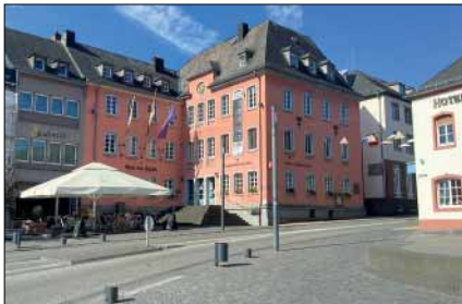
Vor seinem Neuanstrich stach das Gebäude farblich aus der Straßenzeile heraus. Dies sollte nach der Renovierung behoben sein.
