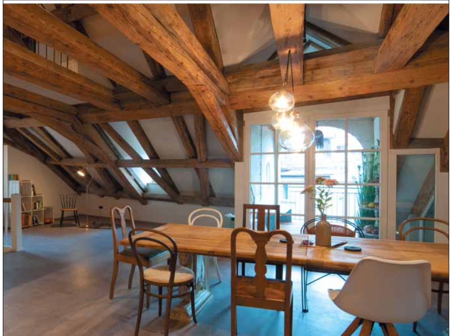
Bauphase und Fertigstellung: Wohnbereich mit Kranengaube. Die Unterseite des Daches ist mit dem Lehmputz-Trockenbausystem mit integrierter Deckenheizung von Naturbo verkleidet.
