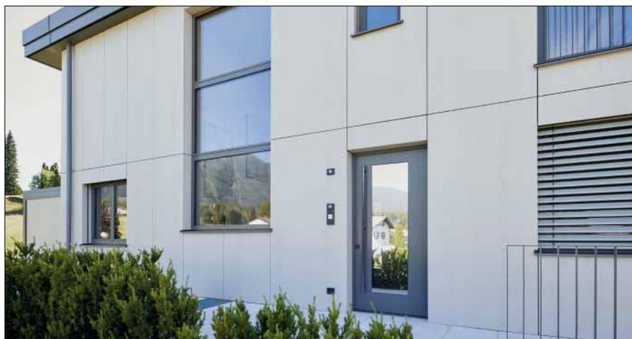
*Geschosshohe Fassadenelemente ermöglichen die Gestaltung einer nahezu monolithischen Gebäudehülle mit perfekt abgestimmtem Fugenbild.*
