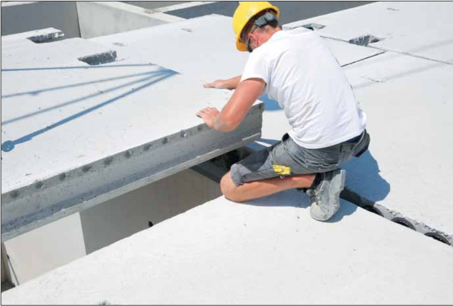
Das Montage-Team richtet die Deckenelemente exakt aus.
