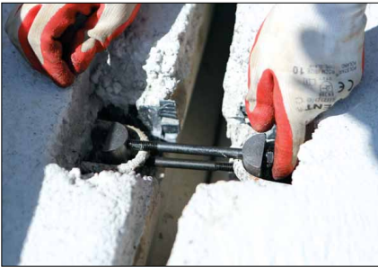
Mit integrierten, patentierten DX-Schlössern werden die Elemente kraftschlüssig verschraubt.
