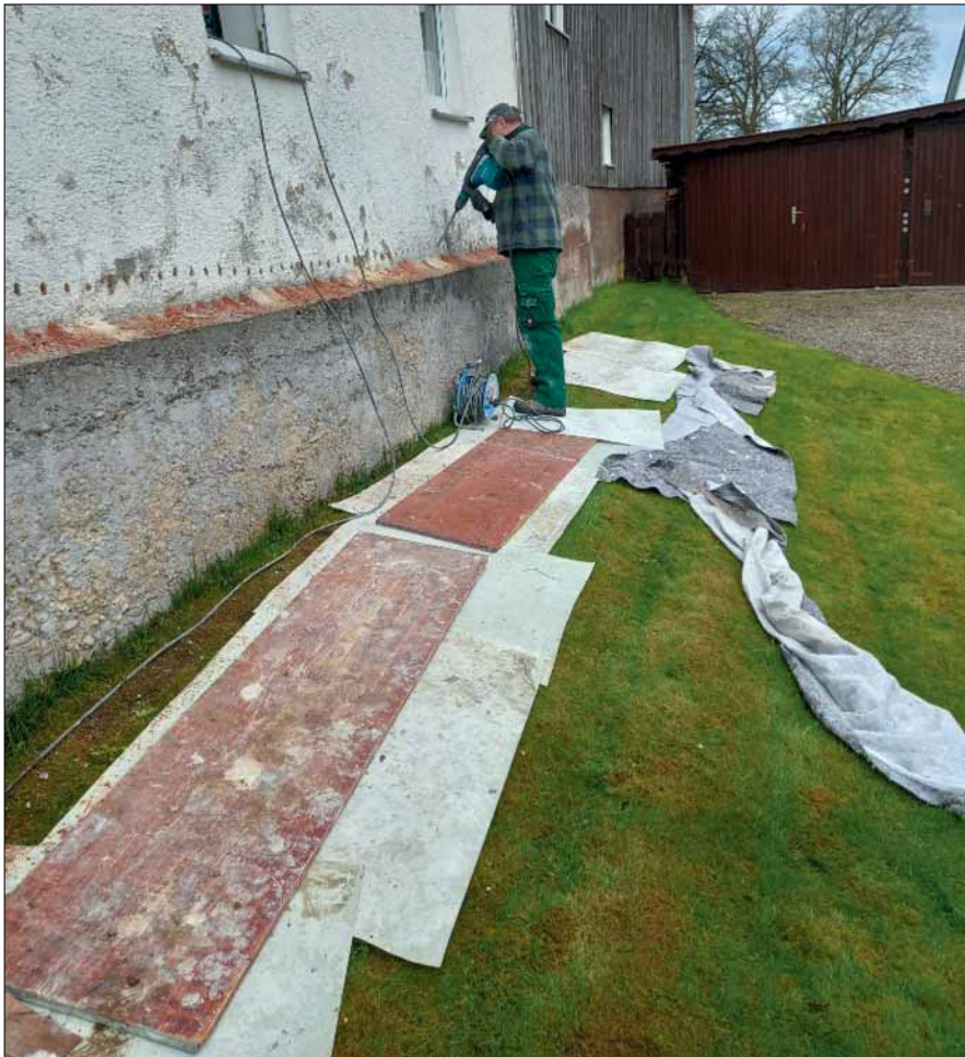
Die Feuchtesanierung erfolgte durch Einbringen einer nachträglichen Horizontalsperre als Querschnittsabdichtung. Dazu wurden zunächst von außen Bohrlöcher im Mauerwerk angebracht.
