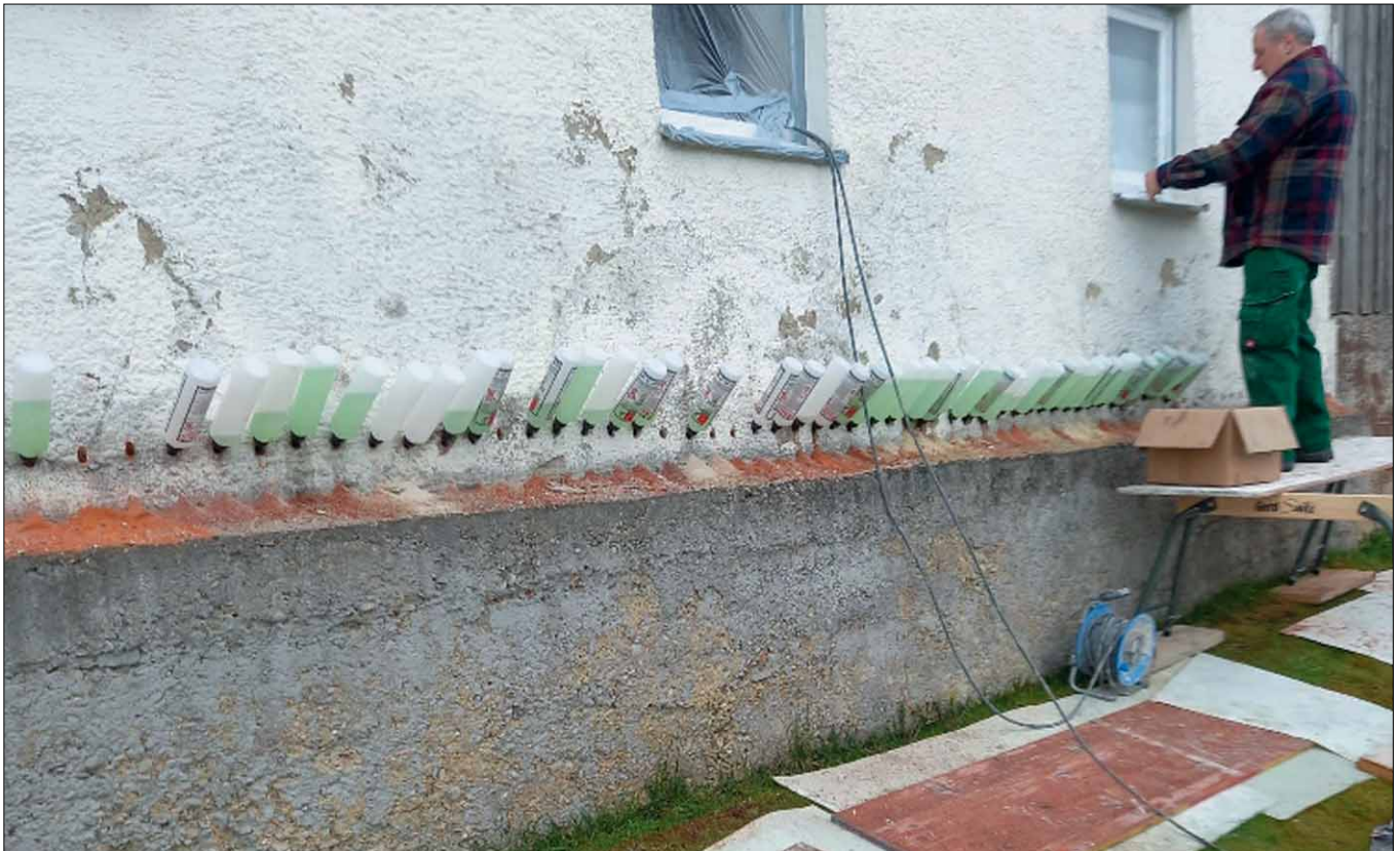
Über die Bohrlöcher wurde die niederviskose, kriechfähige Silikonharzlösung ins Mauerwerk injiziert, die bei Kontakt mit der Feuchtigkeit reagiert und eine unverrottbare Schicht aus polymerem Silikonharz bildet.
