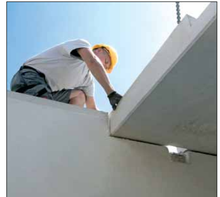
Die DX-Decken wiegen nur 330 kg/m 2 und sind damit deutlich leichter als aufbetonierte Filigrandecken.
