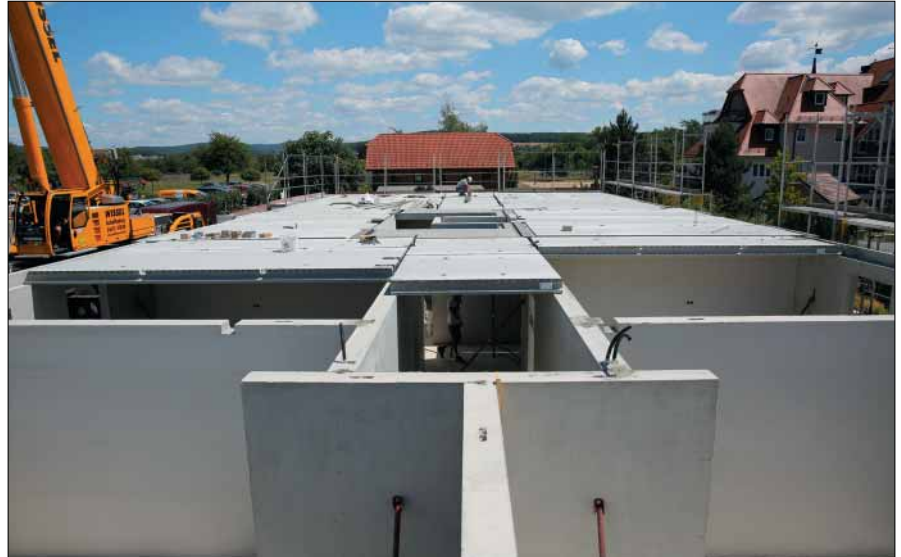
Die DX-Decken wiegen nur 330 kg/m 2 und sind damit deutlich leichter als aufbetonierte Filigrandecken.
