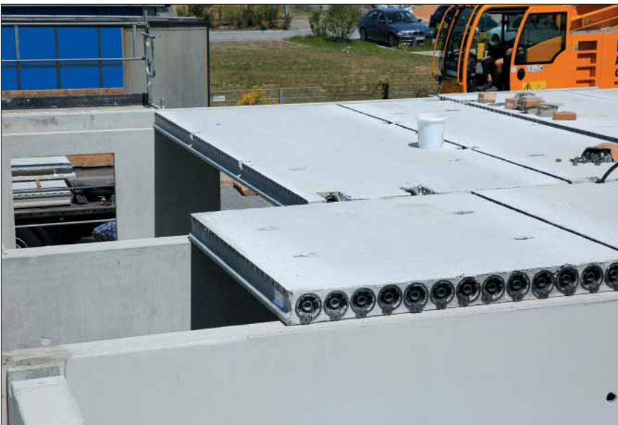
Nach circa zwei Stunden ist die Arbeit des Montage-Teams getan. Anschließend müssen die Fugen und der umlaufende Ringanker bewehrt und mit C25/30-Beton vergossen werden.
