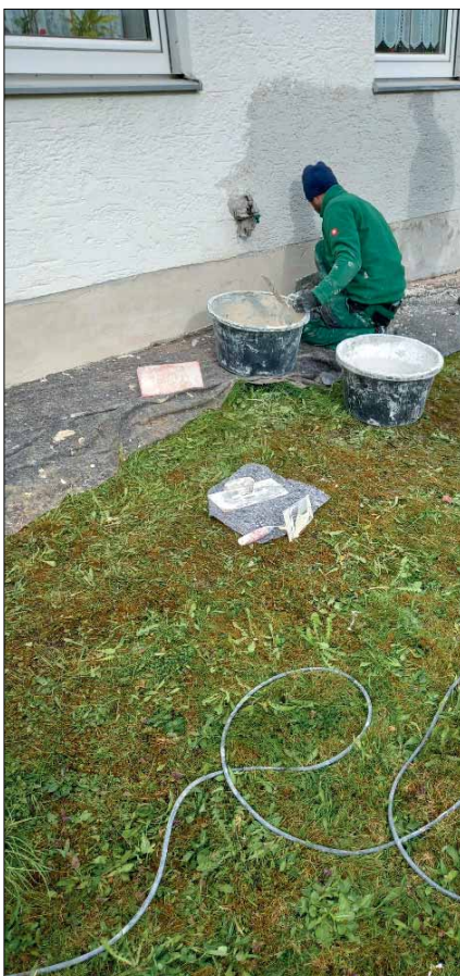
Im Sockelbereich wurde die Sanierung mit einem Spezialputz durchgeführt, der widerstandsfähig gegen witterungsbedingt von außen eindringende Feuchtigkeit ist.
