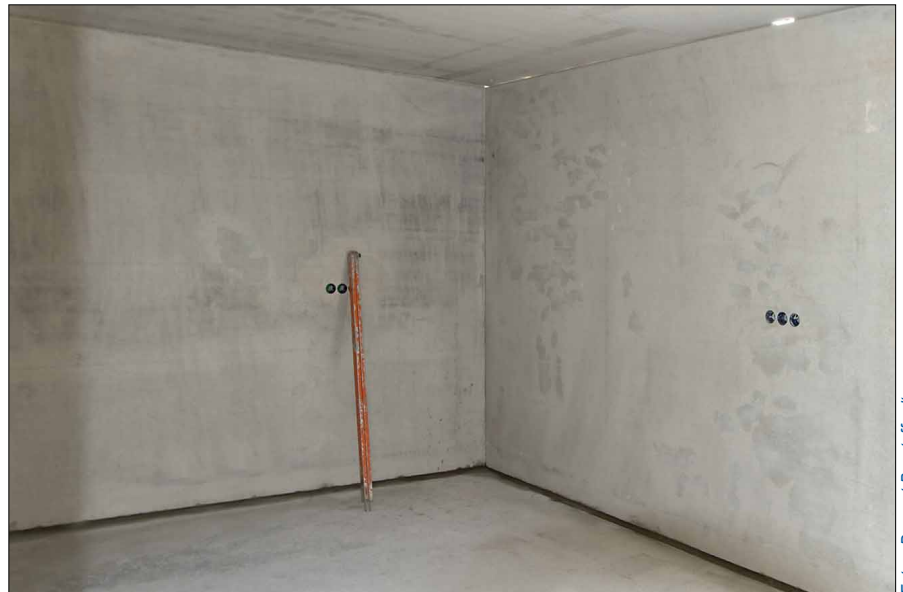
Nach circa zwei Stunden ist die Arbeit des Montage-Teams getan. Anschließend müssen die Fugen und der umlaufende Ringanker bewehrt und mit C25/30-Beton vergossen werden.
